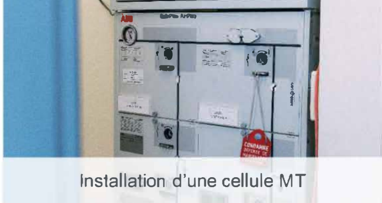
Installation d'une cellule MT
