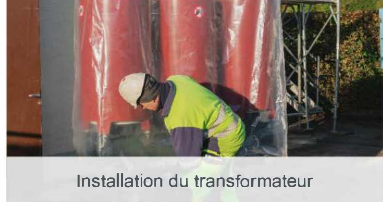
Installation du transformateur
