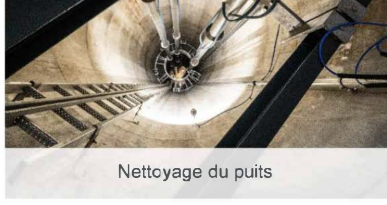
Nettoyage du puits
