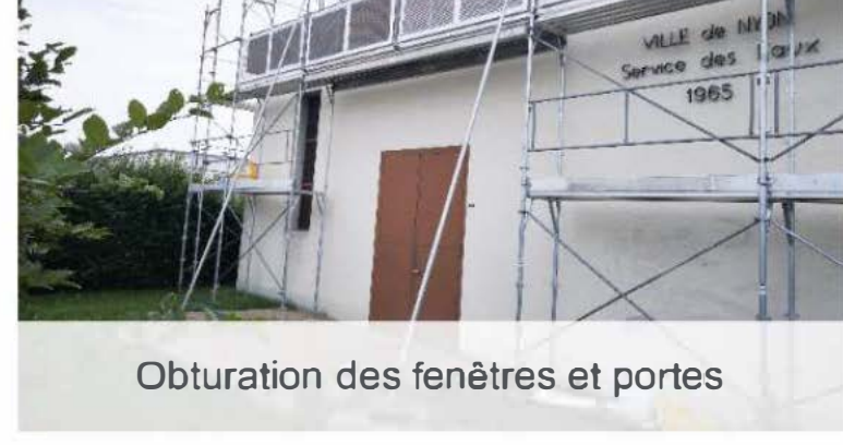
Obturation des fenêtres et portes
