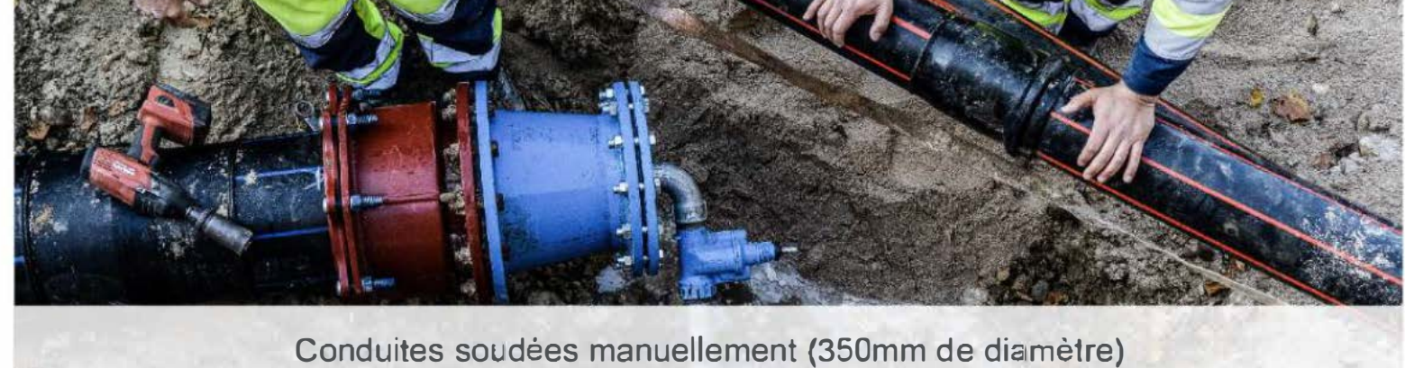
Conduites soudées manuellement (350mm de diamètre)
